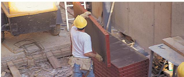
El Sistema Steel-ply Muros es realmente ligero, con sólo 24 kg/m<sup>2</sup>, por lo tanto su uso ideal se corresponde con aquellas obras que no disponen de grúa. A pesar de ello, la alta gama de accesorios de Steel-Ply Muros permite el montaje de grandes pantallas para su manipulación y colocación con grúa.
