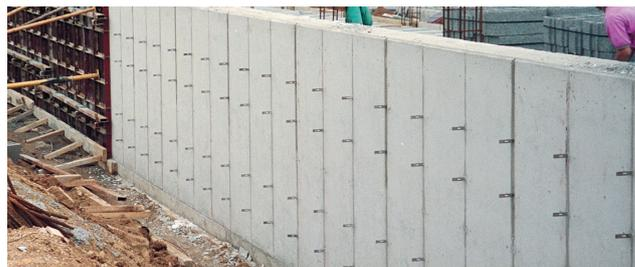
La superficie de encofrado es un tablero de contrachapado fenólico de 12 mm de espesor que proporciona un acabado de hormigón visto, con una presión admisible de 48 kN/m<sup>2</sup>.
