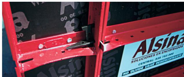
La unión entre paneles se realiza mediante cuñas rápidas que se acoplan entre sí y se aseguran con un golpe de martillo. Una vez montada una de las caras del muro, la otra cara se alinea automáticamente mediante los tirantes que sujetan las dos caras del encofrado.
