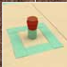
Penetración de tuberías
