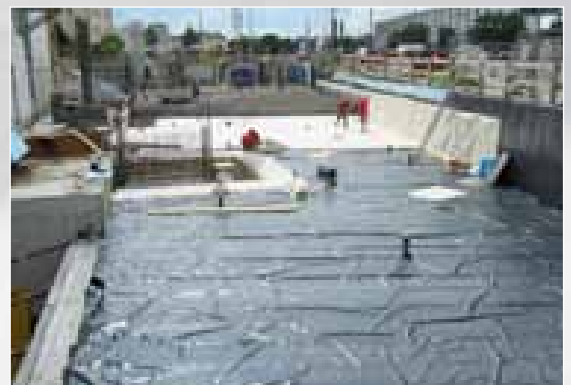
Armado de losa base
