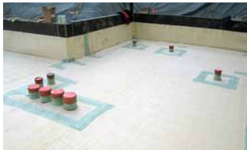
Detalle de una junta interna terminada
