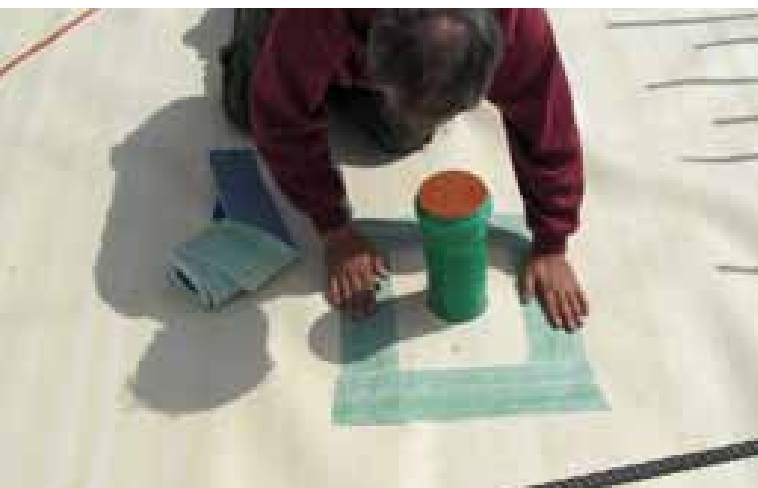
Detalle de una junta interna con SikaProof® Tape -150
