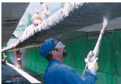
Proyección de hormigón o mortero
