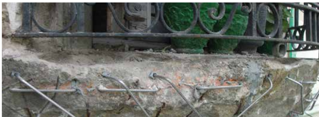
Anclaje de barras de espera con taco químico
