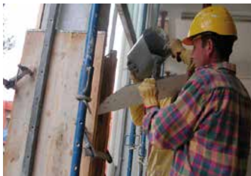
Reemplazamiento del hormigón deteriorado con relleno de mortero vertido
