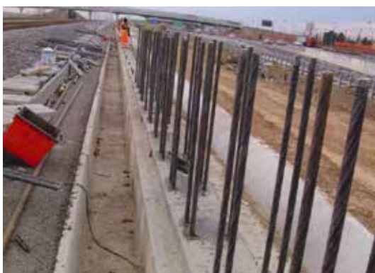
Anclaje de pilar
