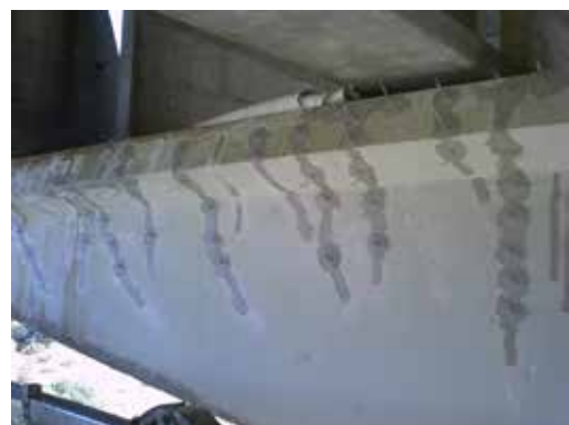
Inyección en viga
