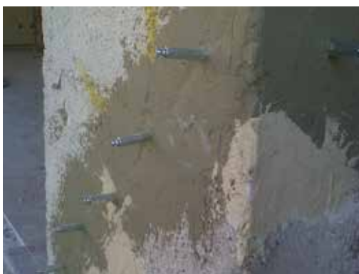
Inyección en pilar
