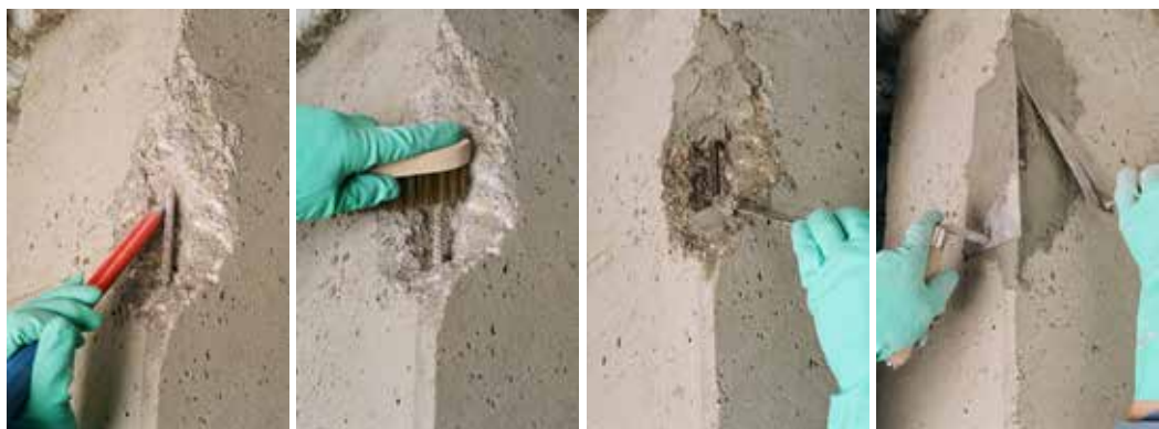
Reparación de un pilar
