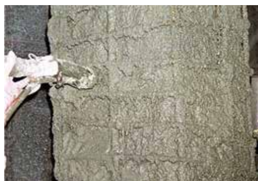
Aumento de recubrimiento de la armadura por proyección
