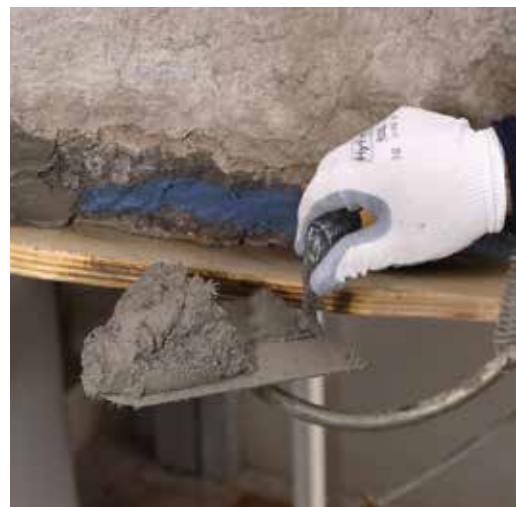
Retacado de una viga
